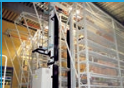
ケースピッキングクレーン
