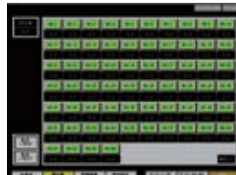
PROFIBUS-DP通信システム 状態監視画面
