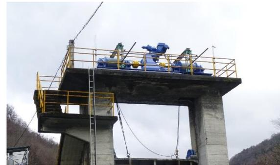
近年、発電設備用の取水口ゲートなどに使用されていたワイヤードラム式開閉機の更新需要がある。
